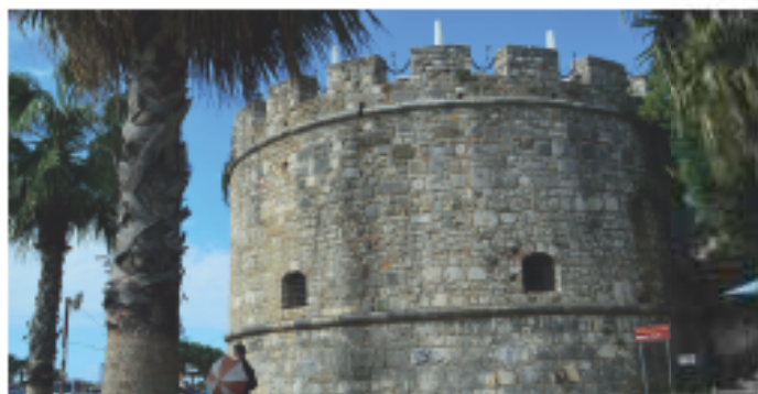
Venecijanska kula u Draču podignuta na temeljima vizantijske građevine
